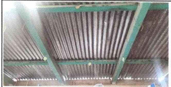
Foto 4: Vigas en mal estado
